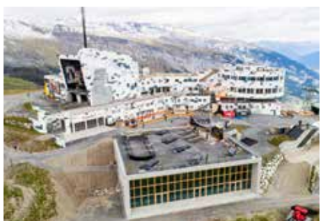
Hangar moderno sul Crap Sogn Gion, Laax
